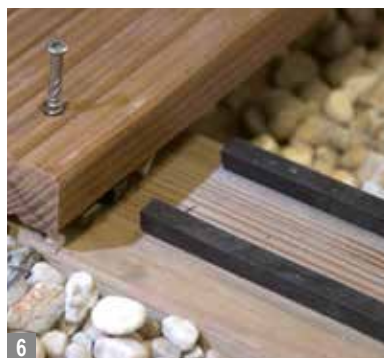
6 Praktisch: Selbstklebendes Ausgleichsband reguliert Unebenheiten.
