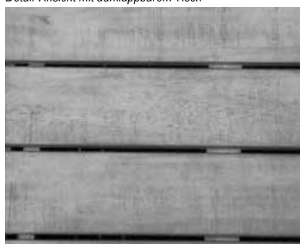
Detail-Ansicht der Oberfläche
