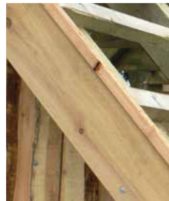
Lärchen – Dachstuhl im Detail
