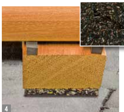
4 Gummi reguliert: Höhenausgleich-Pads für die Unterkonstruktion.
