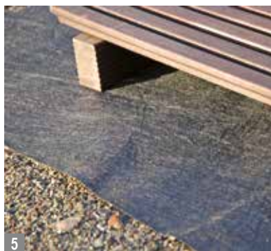
5 Wasserdurchlässiges Abdeckvlies gegen Durchwurzlung und Pfützenbildung.
