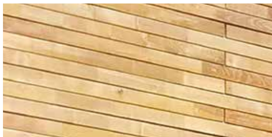
Rhombusprofil 21 x 60 mm
